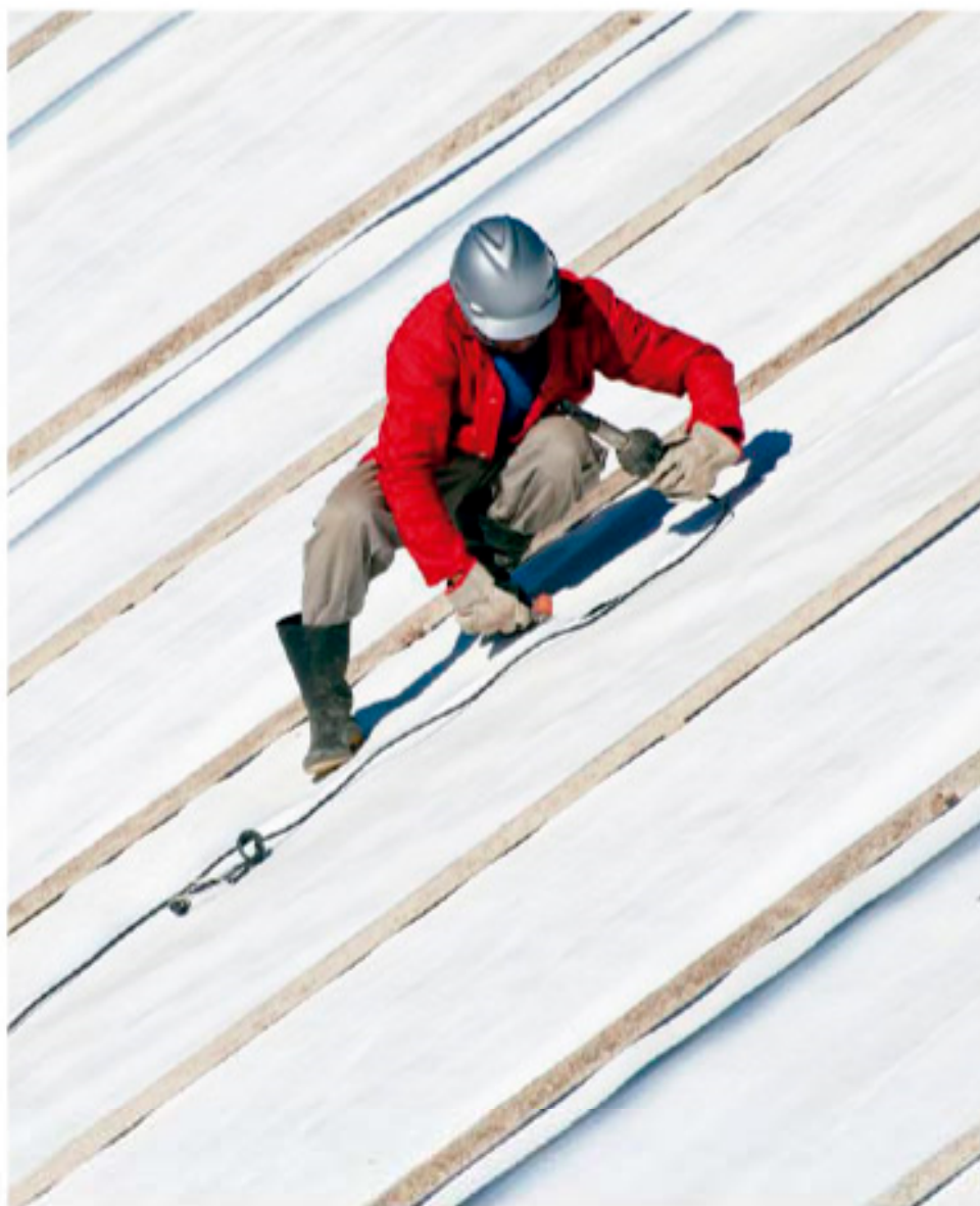
Obras adjacentes para receber águas da transposição
